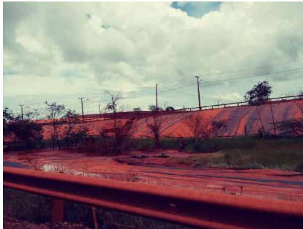
Figura 6: Evidências de transbordo de efluentes em bacia de resíduos localizada na DRS1. Mantas tomadas de resíduos de lama vermelha.
